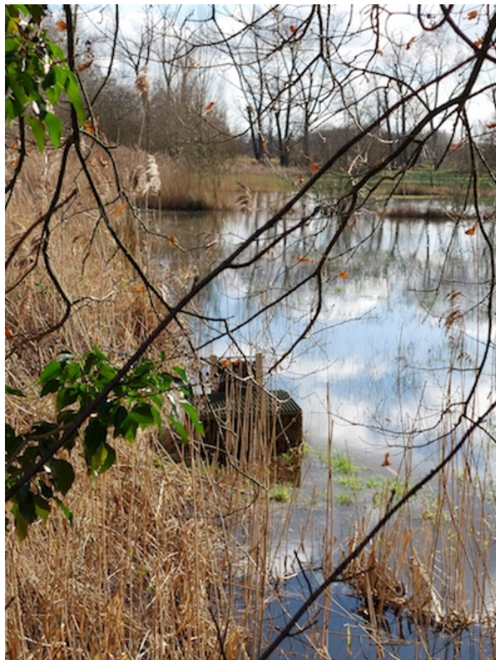
door de verstoorde afwatering werd het stuwputje, dat 's-zomers het water moet tegenhouden, nu geheel omringd door water
